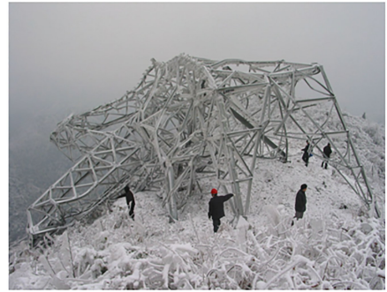
(b) 覆冰导致的杆塔倒塌
